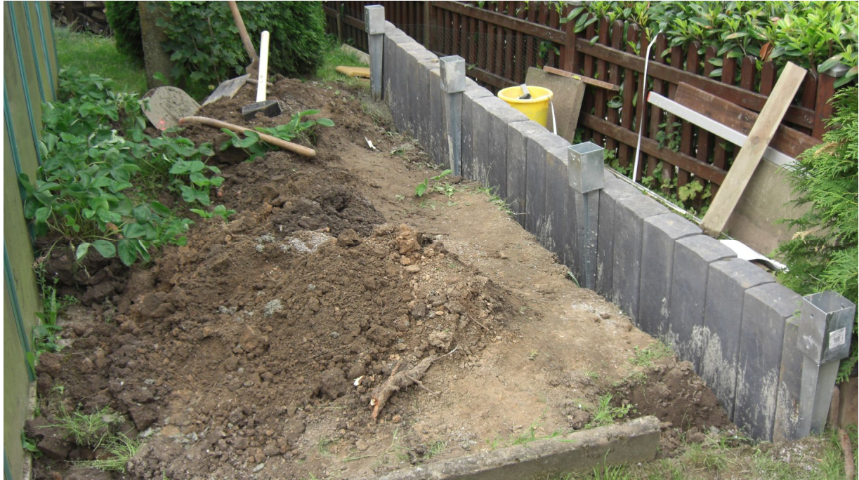
Bild 1: Für das Hochbeet muss leider ein kleiner Erdbeer- und Gemüsegarten weichen. Weil das Gelände nach rechts abfällt, müssen zuerst Stützpalisaden aus Beton gesetzt und einbetoniert werden. Die innen 91 x 91 mm messenden Pfostenträger (Einschlaghülsen, s. rechts) stehen zu diesem Zeitpunkt noch zu hoch, ihre Oberkanten sollen mit den Oberkanten der Palisaden bündig abschließen, um später die optimale Arbeitshöhe von ca. 80 - 85 cm zu erreichen.
