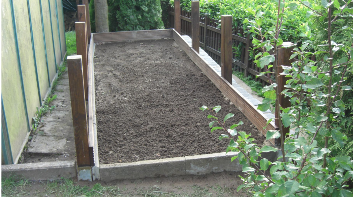
Bild 3: An der Längsseite links und an den beiden Schmalseiten werden unten Randsteine gesetzt und teilweise einbetoniert. Die Oberfläche wird mit Gartenerde bis kurz unter die Seitenbretter angefüllt und leicht verdichtet, so dass eine annähernd ebene Fläche entsteht. Hierauf wird später das Mäuseschutzgitter ausgelegt.
