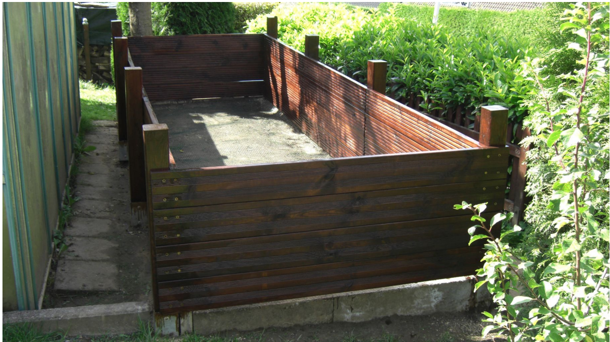
Bild 5: Die große „Pflanzkiste“ ist fast fertig. Am Boden ist das verzinkte und kunststoffbeschichtete Mäuseschutzgitter zu erkennen, das eine Drahtstärke von 1,3 mm und eine Gitterweite von 12 x 12 mm aufweist. Dieses Gitter ist rollenweise in Maßen von 130 x 500 cm (B x L) erhältlich. Alle Seitenbretter werden abschließend innen und außen mit Dauer-Wetterschutzlasur noch einmal gestrichen.
