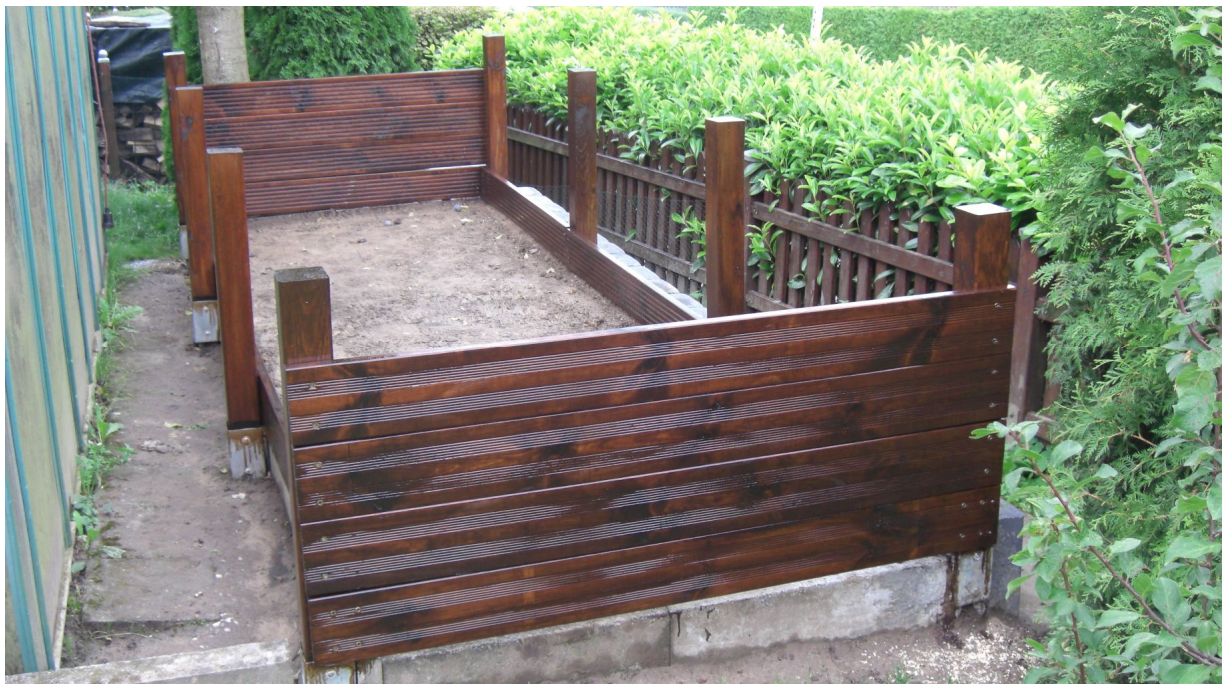
Bild 4: Die restlichen Seitenbretter werden angeschraubt. Weil Bretter und Pfosten aus Kiefernholz gefertigt sind, müssen alle Holzteile (trotz Kesseldruckimprägnierung) abschließend mit Wetterschutzlasur 2x gestrichen werden. Das fertige Hochbeet ist 3,95 m lang, 1,50 m breit und ca. 0,75 m hoch (Außenmaße). Innen misst das Hochbeet 3,90 m (Länge) x 1,27 m (Breite) x 0,58 m (Höhe), das entspricht einem Gesamtvolumen von 2,87 m 3 .
