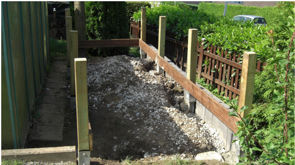
Bild 2: Die 4 rechten Pfostenträger werden zusammen mit den Stützpalisaden einbetoniert. Die 4 Pfostenträger links werden ca. 75 cm tief in den Boden eingeschlagen. Die 8 Pfosten aus Fichtenholz sind kesseldruckimprägniert, jeweils 90 cm lang und 9 x 9 cm dick. Die Seitenwände bestehen aus kesseldruckimprägnierten Terrassendielen (8 Stck. jeweils 150 x 14,5 x 2,3 cm für die Kopfseiten, 24 Stck. jeweils 130 x 14,5 x 2,3 cm für die Längsseiten).
